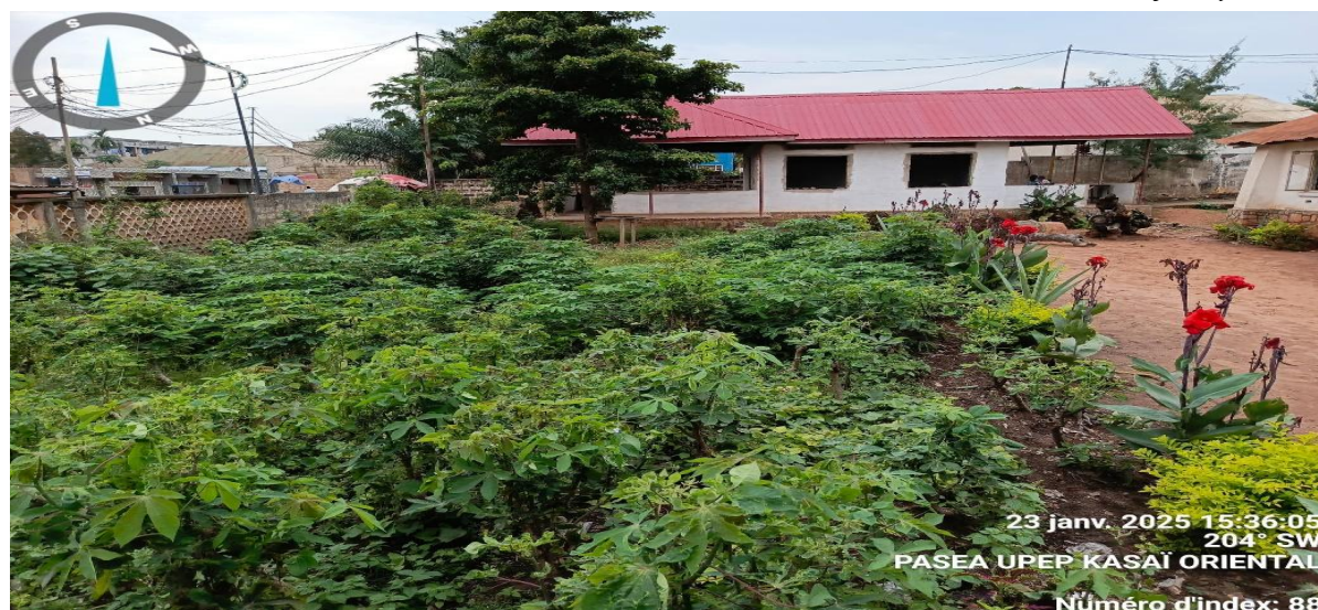
Photo1 : Vue initiale du site de construction du bâtiment de l'UPEP-KOR à Mbujimayi
