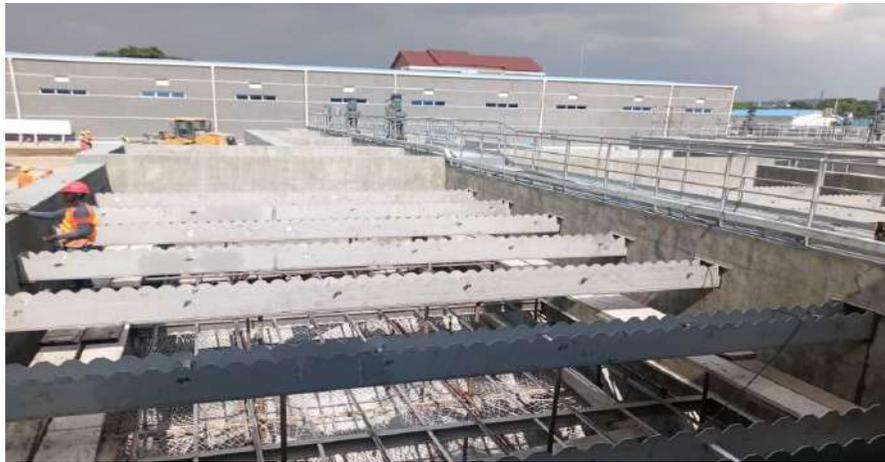
Montage des goulottes des décanteurs
